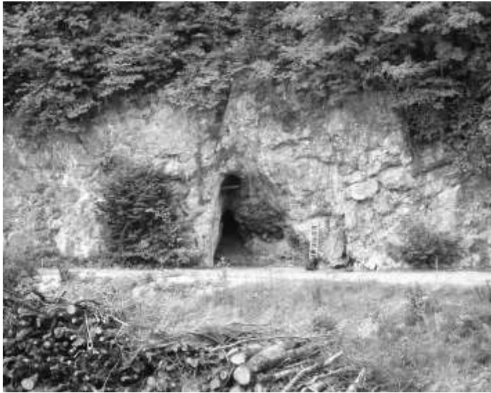
Oben: Ansicht der Felswand mit der Höhle, davor die Kiesstrasse auf der Rampe.
