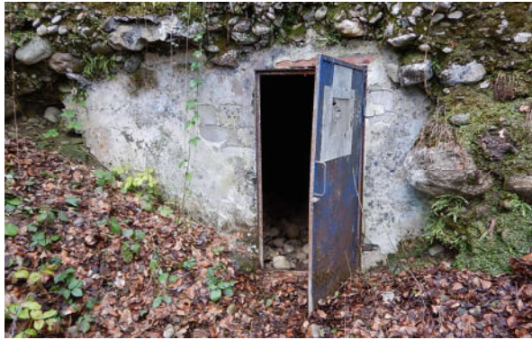
Zugangstüre Quellwasserfassung, Foto TB
